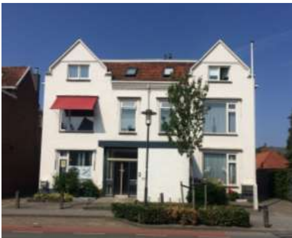
Belastingkantoor nu met appartementen
