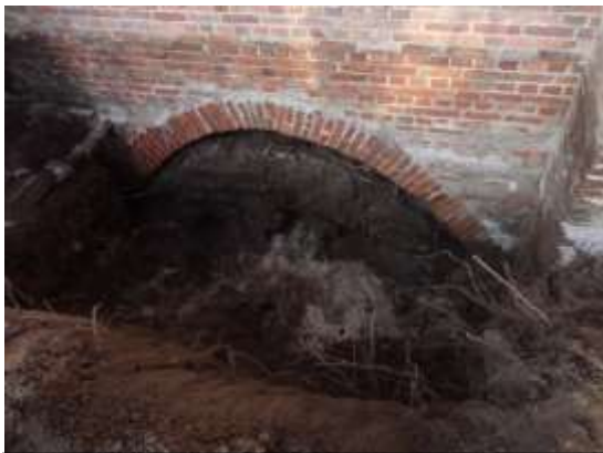
De grote boog onder het maaiveld onder de zuid muur van de Sprangse kerk.
